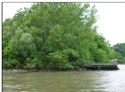
1 - Riprap shore protection
